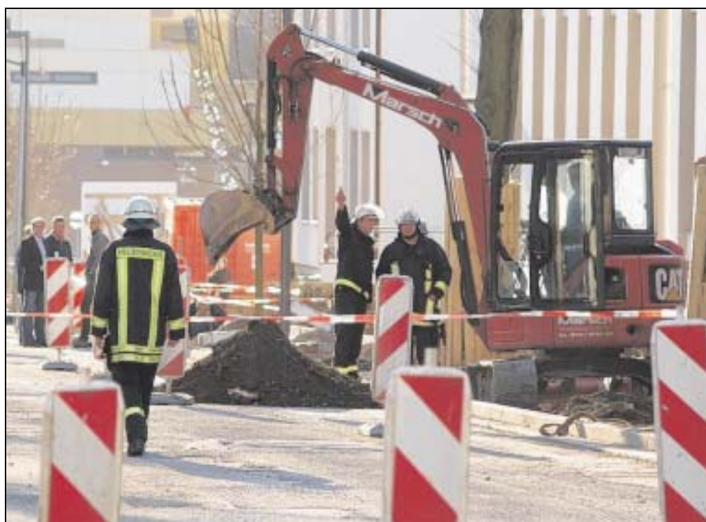
Den Bereich rund um das Leck sperrten Feuerwehr und Polizei weitläufig ab. Mit einem Bagger wurde das defekte Gasrohr vorsichtig freigelegt. Foto: Engel
